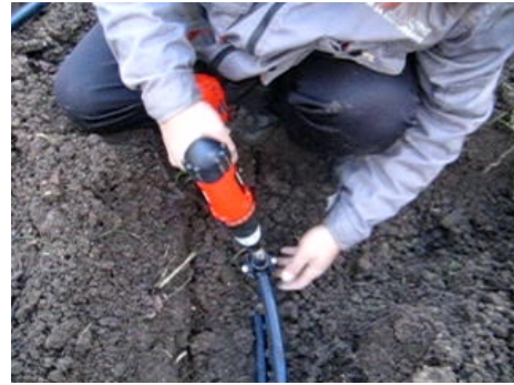
Пробиване на отвор в ПЕ тръбата
