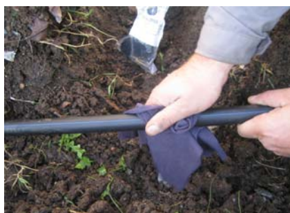
Почистване на полиетиленовата(ПЕ) тръба от механични замърсители
