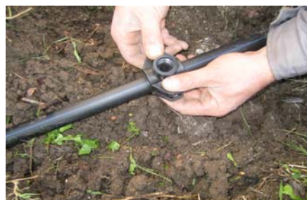
Закрепва се горната част на водовземната скоба към вече положената основа и се пристяга с болтовете
