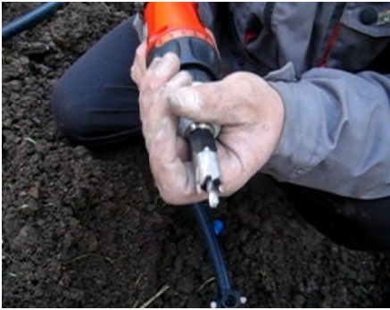
Поставяне на необходимия диаметър фрезер на акумулаторната машина
