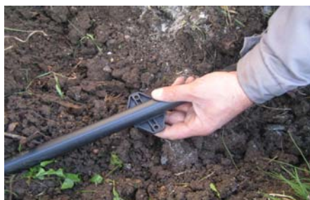
Монтира се долната част на скобата към ПЕ тръбата
